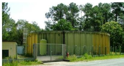
Cette station est composée d'un forage, d'un traitement (désinfection), et d'une station de reprise avec une bache d'une capacité de 1000 m3.
